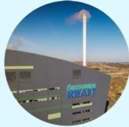
Förbränning och produktion av fjärrvärme
